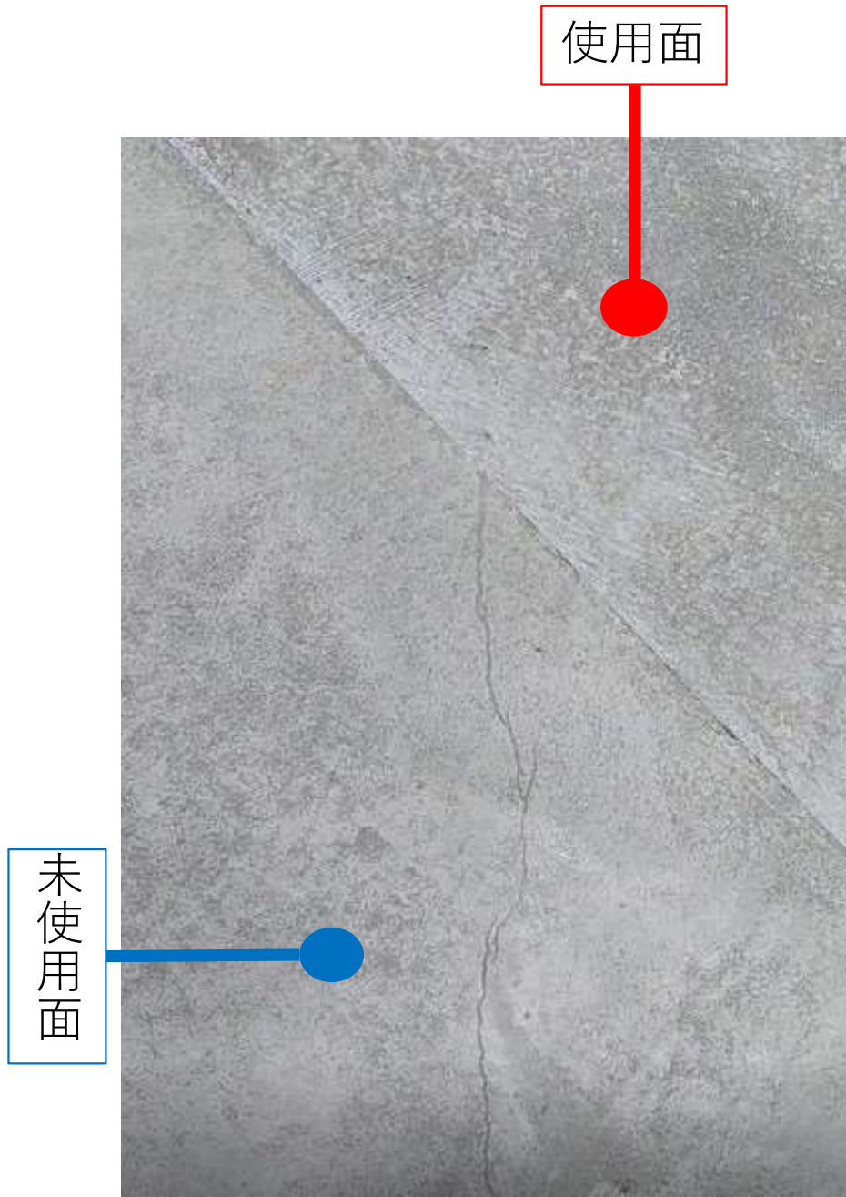
2022年11月26日 施工 (午前中雨天)
